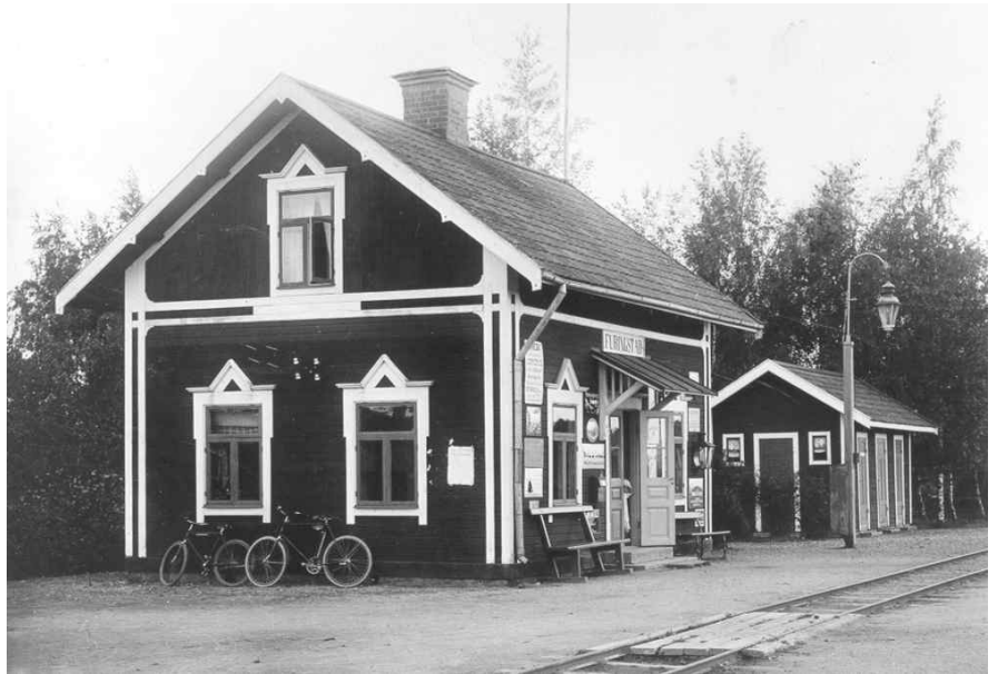
Furingstad hållplats som 1912 genomgått en genomgripande reparation.
