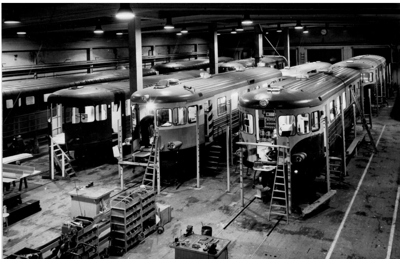
Stämmingsfull bild från slutmontering av rälsbussar i en av ASJ:s vagnhallar någon gång 1953/54. De högra rälsbussarna ingick i den beställning som Göteborg - Särö Järnväg gjorde av 5 st. rälsbussar och 3 st. släpvagnar. Dessa var av samma typ som SJ beställde, d.v.s. YCo6 men hade lite annan målning. GSJ rälsbussarna och två av släpvagnarna hamnade i Afrika hos LAMCO efter avslutad tjänst i Sverige.
